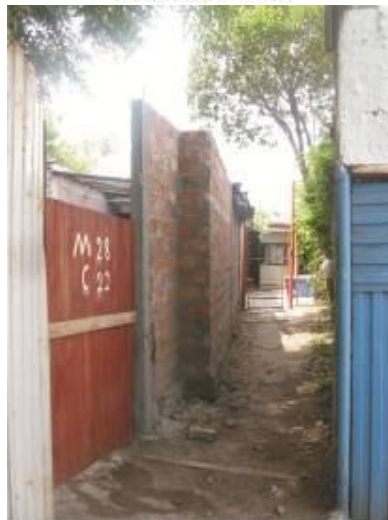
Pasillo del asentamiento. Fuente: Fundación TEMAS
