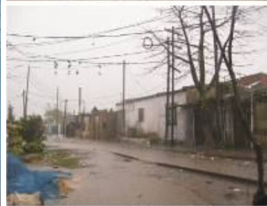
Falta de Infraestructura básica (Agua, Desagües y Calles). Fuente: Fundación TEMAS
